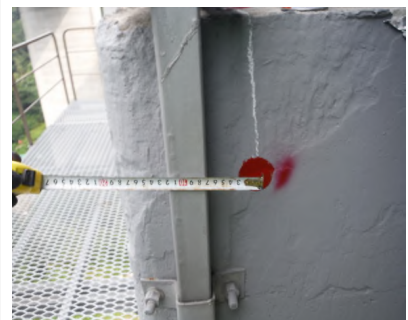
교각(P4) 측량점 표기현황
