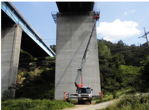
고소점검차 및 디스크프(망원경)를 이용한 외관조사
